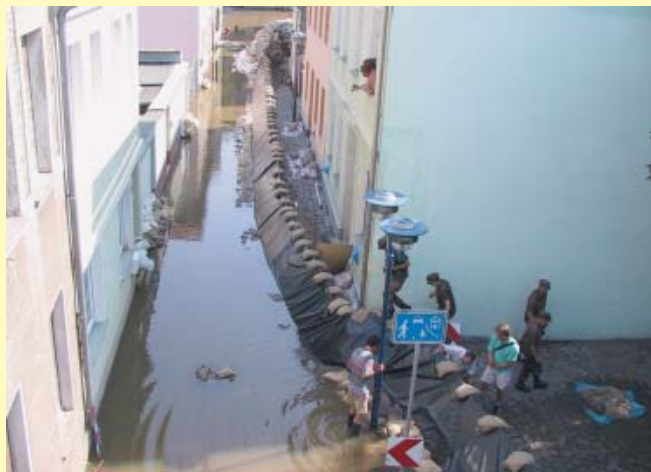
Bild 2 Der Schnellbaudamm aus Köln erleichterte die Sicherung der Innenstadt
