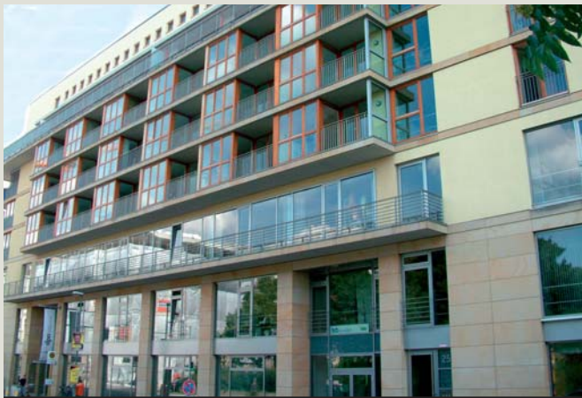
Im »Medienhaus am Deutschen Theater« entsteht die neue DFV-Bundesgeschäftsstelle. (Foto: M. Vogt)
