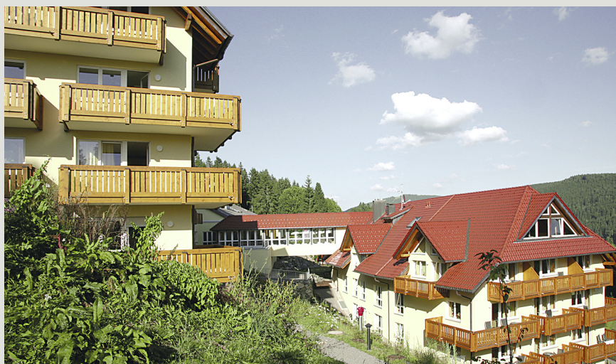
Das Ferien- und Gästehaus Sankt Florian in Titisee-Neustadt erstrahlt nach umfangreicher Modernisierung in neuem Glanz. (Foto: LFV BW)
